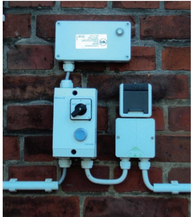
Funkfernsteuerungsempfänger mit Motorschutz
